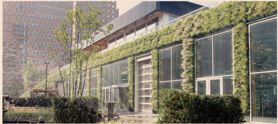
Ad Amsterdam. Un'immagine di Circl, edificio di circa 3.400 mq voluto dall'Istituto di credito Abn Amro e realizzato con materiali ricavati da altre strutture demolite nella città. Alcuni rivestimenti sono in jeans
